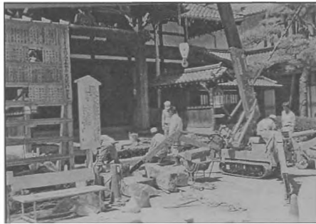
Fot. 30. Miniaturyzacja sprzętu budowlanego – technika w służbie sacrum, Tokio 2000 [fot. autora]
